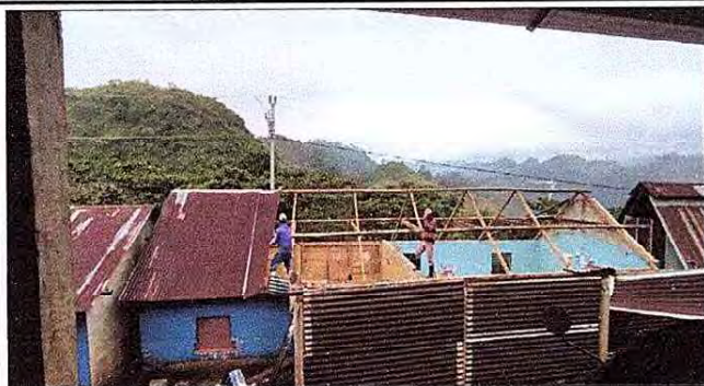
Foto 1: Se puede observar a los señores quitando toda la parte del techo antiguo para su posterior reemplazo.
