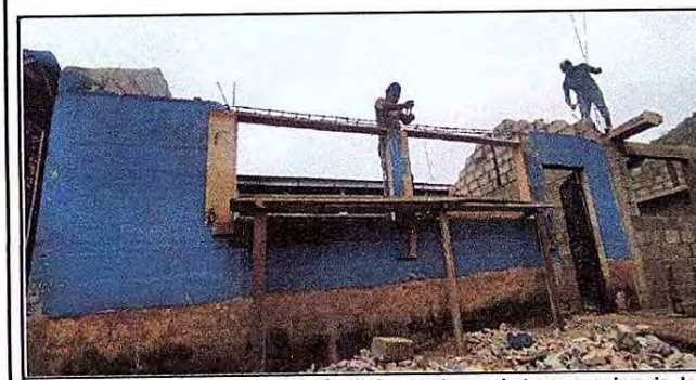
Foto 5: Mejoramiento y ampliación de las ventanas de tercero primaria, las que tenían actualmente no contemplaban las medidas recomendadas en un salón de clases.
