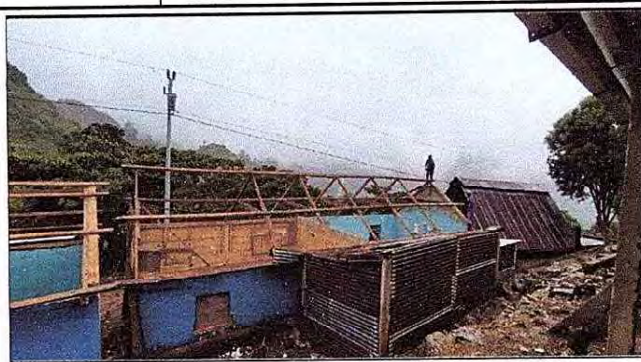
Foto 2: Eliminación de la cubierta de lamina antigua en su totalidad, gracias al apoyo de oadres de familia.
