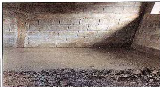
Foto 3: Sustitución total del entortado anterior por uno con material adecuado y resistente.
