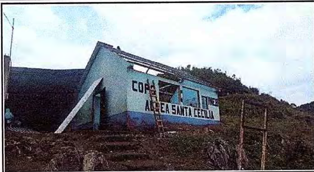
Foto 1: Se puede observar las ventanas del salón de prepa 3, ya amplidas según las recomendaciones que se nos brindaron.
