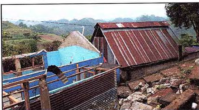
Foto 3: El salon de 3° primaria ya sin la cubierta antigua, listo para su colocación de la nueva estructura de metal.
