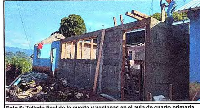
Foto 6: Tallado final de la puerta y ventanas en el aula de cuarto primaria.
