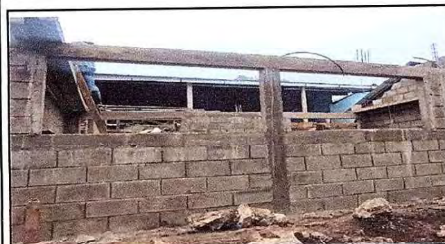
Foto 3: Se puede observar el acabado final de las ventanas de enfrente, listas para la colocación de las ventanas de metal.
