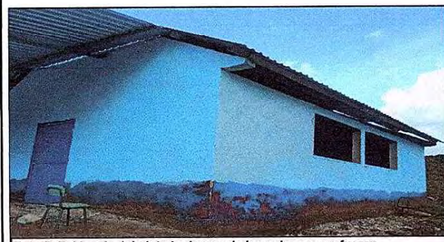
Foto 5: Evidencia del pintado de uno de los salones que fueron intervenidos con el programa de remozamiento.
