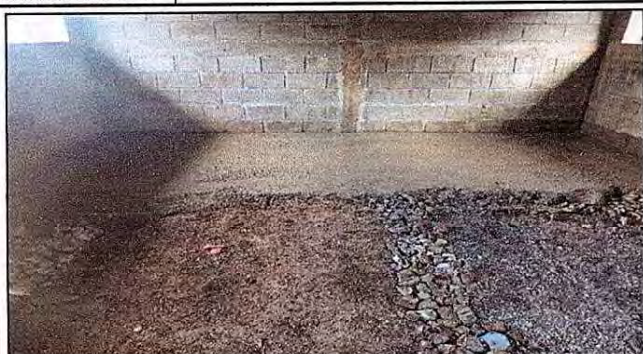
Foto 1: El salón de cuarto primaria, con la sustitución del entortado anterior por uno ya mejorado.
