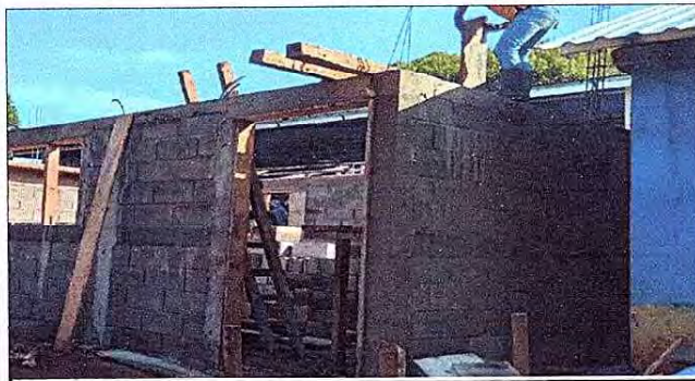
Foto 3: El salón de 4° primaria, ya con su puerta modificada, y con las condiciones adecuadas.
