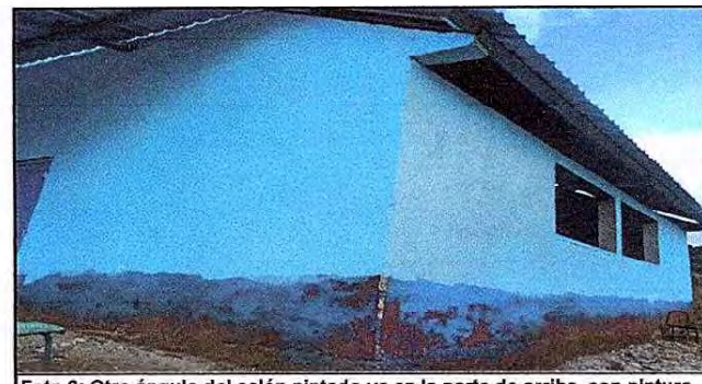
Foto 6: Otro ángulo del salón pintado ya en la parte de arriba, con pintura de agua.
