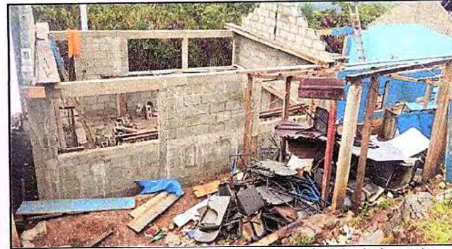
Foto 4: Evidencia de la ventanas de la parte de atrás del aula de cuarto primaria, que tambien se mejoraron para una mejor iluminación en el salón de clases.
