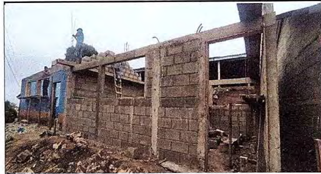
Foto 4: Mejoramiento de las ventas de cuarto primaria, con las medidas recomendadas para una mejor iluminación.
