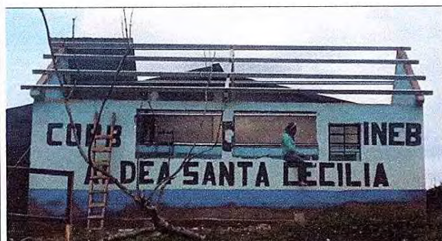
Foto 3: El salón de prepa 3, con el cambio total de la estructura de las costaneras de metal.
