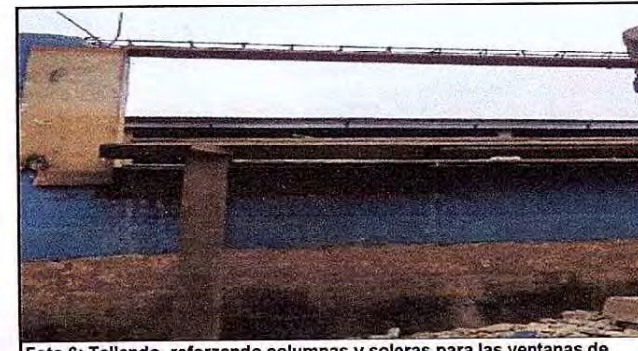
Foto 6: Tallando, reforzando columnas y soleras para las ventanas de tercero primaria.
