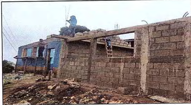
Foto 2: Evidencia de las ventanas que se mejoraron en aula de cuarto primaria.
