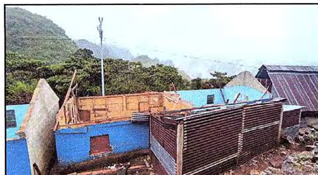
Foto 4: El módulo de 3° y 4° primaria ya sin la cubierta de lámina antigua y sin la estructura de madera que se utiliza como costaneras.
