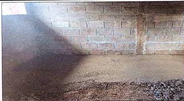
Foto 2: Parte interna del aula de cuarto primaria con la sustitución del piso anterior.
