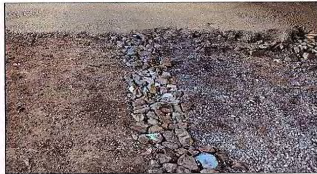
Foto 4: Evidencia del entortado implementado en el módulo de tercero y cuarto primaria.
