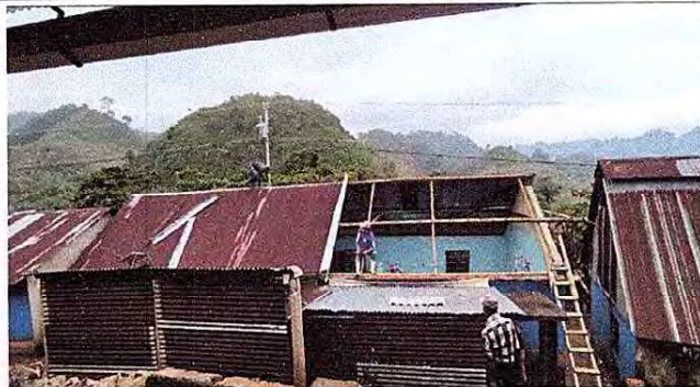
Foto 2: El módulo de 3° y 4° primaria, quitándole la cubierta de lámina que se cambiaría.
