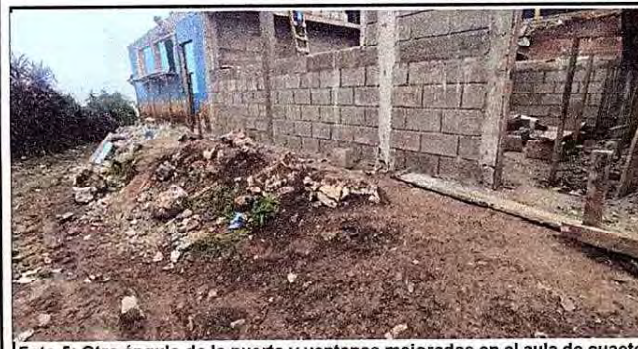
Foto 5: Otro ángulo de la puerta y ventanas mejoradas en el aula de cuauto primaria.
